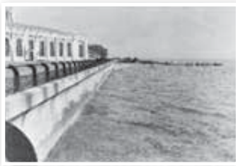
Usine de purification R.C. Harris, vue du puits du tunnel, 2 septembre 1953
