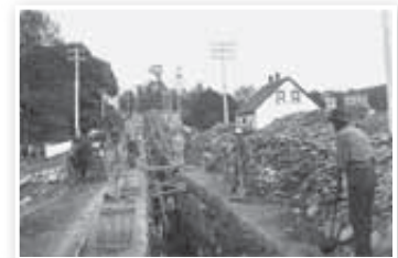
Tranchées d'égouts et d'eau, Dartmouth, 1900
