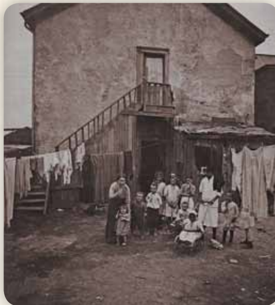
Arrière-cour, 512, rue Front Est, Toronto, août 1914
